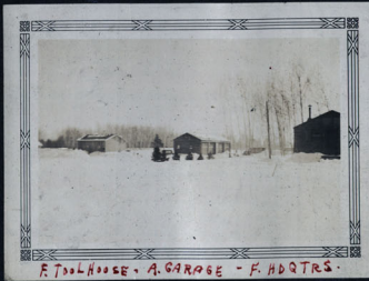
F. TOOLHOUSE - A. GARAGE - F. HQTRS.
